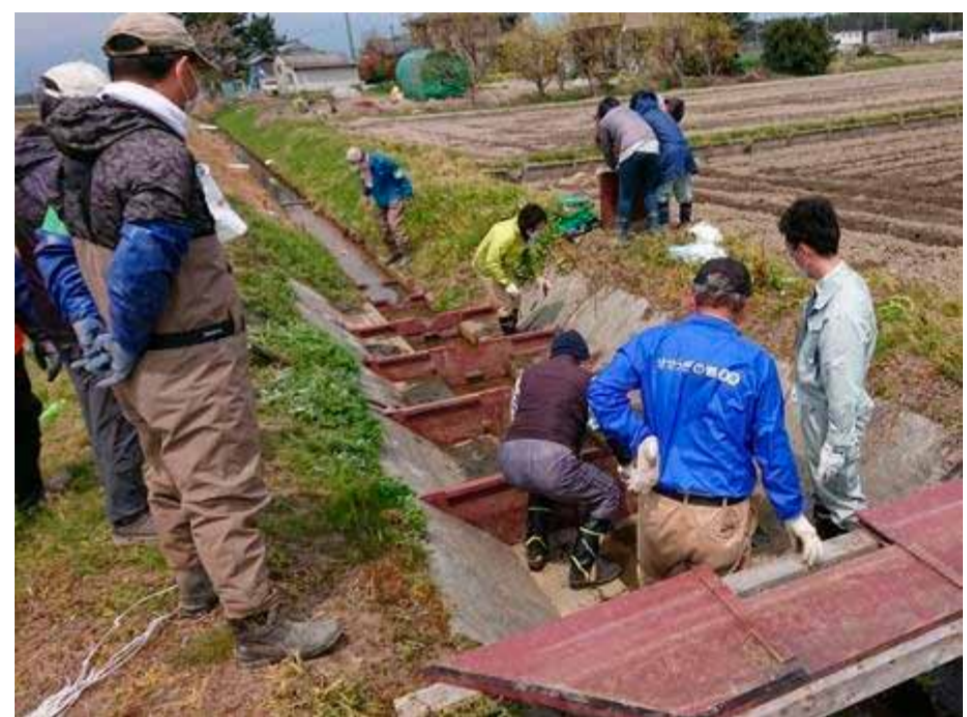
野洲市須原での魚道設置作業
