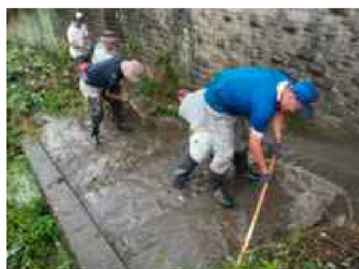
魚道の土砂を除去しています
