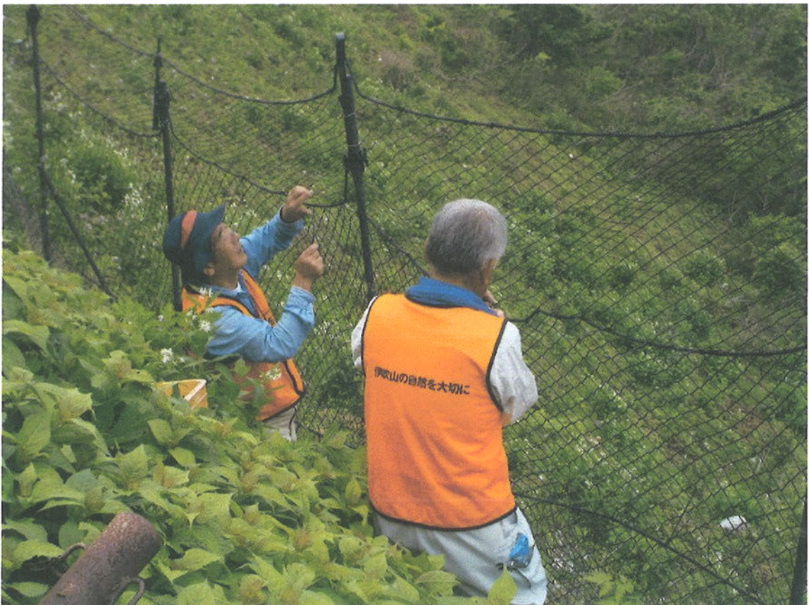
植生防護柵ネットの修繕
