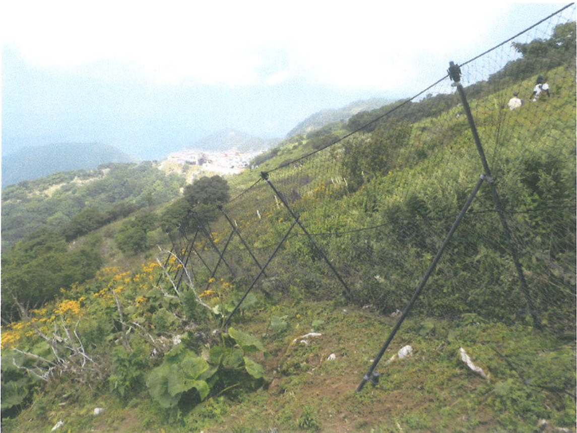
植生防護柵の張り替え・強化ネットの設置（西登山道エリア）
