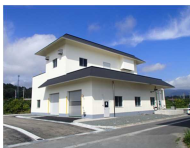
図 5-50 共同汚泥処理施設
