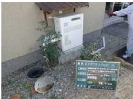
図 5-37 誤接続調査状況
