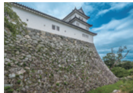
10-meter-high castle wall. 10m以上に及ぶ石垣の上に築かれている。
