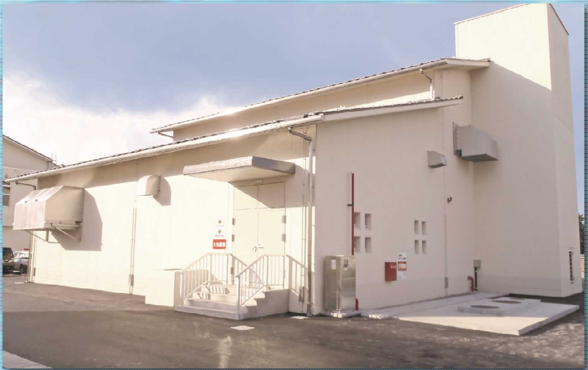
吉川自家発電棟
