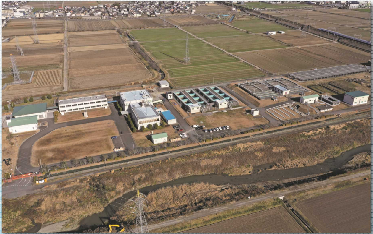
馬渕浄水場外観
