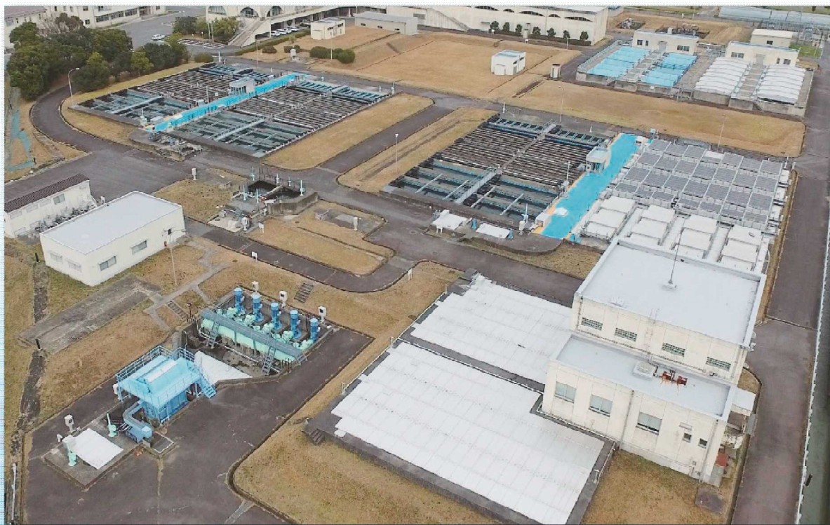
吉川浄水場外観
