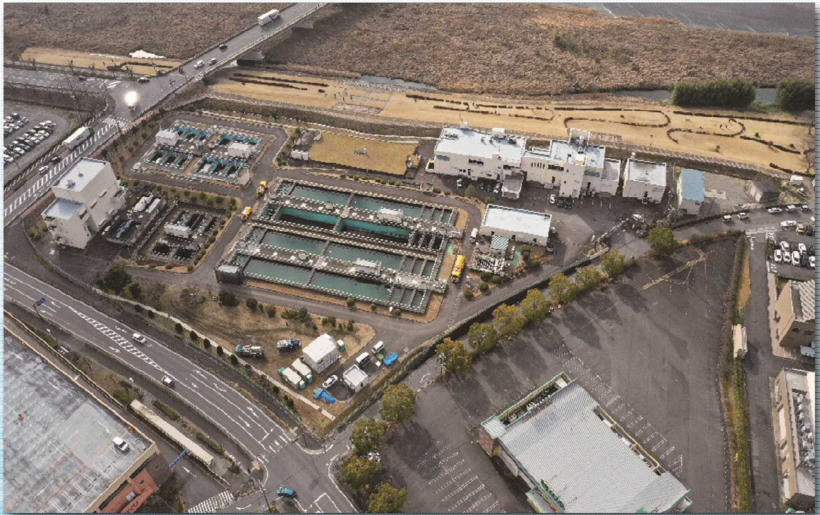
水口浄水場外観
