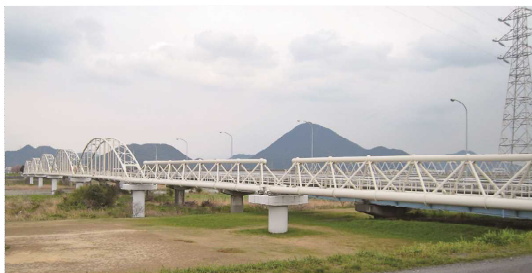
野洲川2号水管橋
