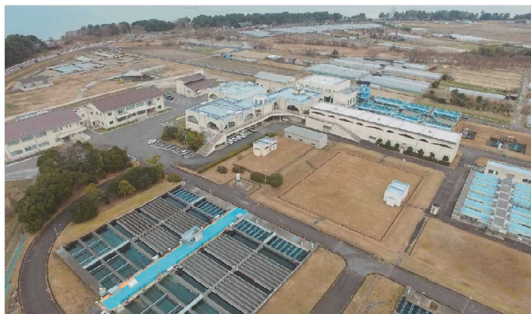
吉川浄水場(工水 沈殿池、浄水池)
