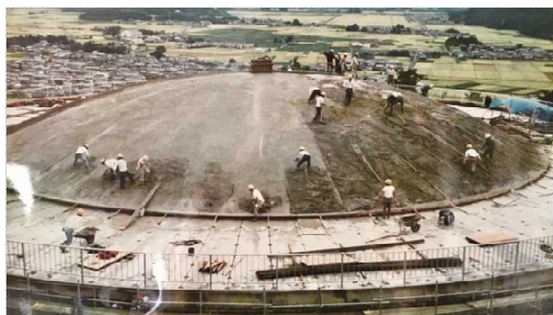
瓶割山調整池建設中
