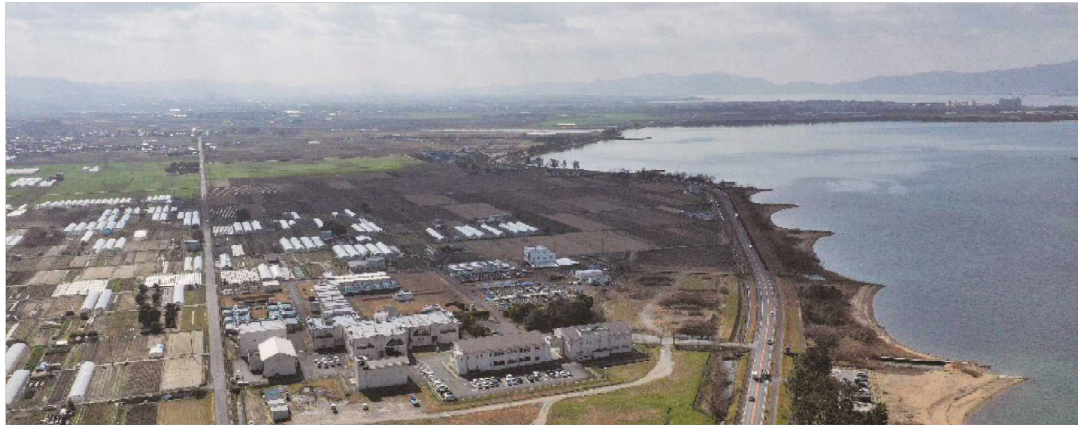
上空から撮影した吉川浄水場
