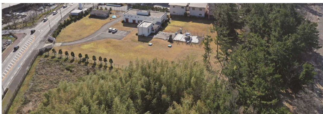
上空から撮影した彦根浄水場
