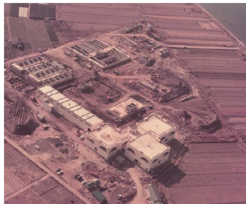
吉川浄水場当初建設中
