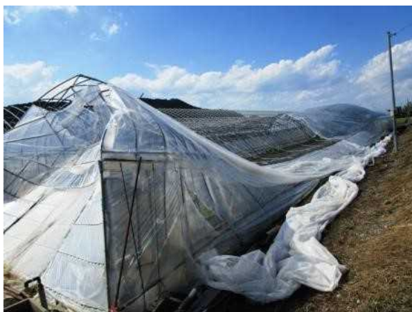
236 237 238 239 240 241 242 243 244 245 台風による農業用ビニルハウスの倒壊(2018年9月の台風21号)
