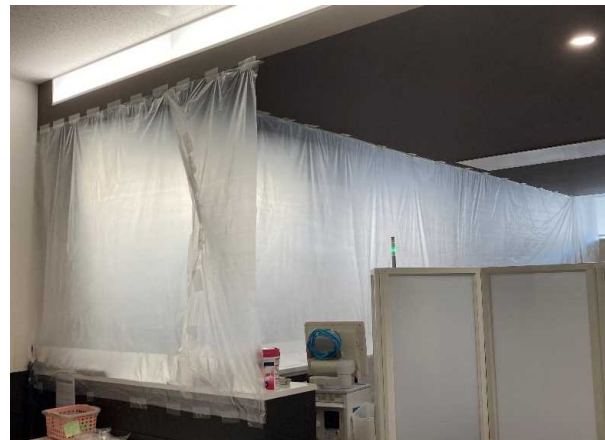
じん臓病センターの間仕切り
