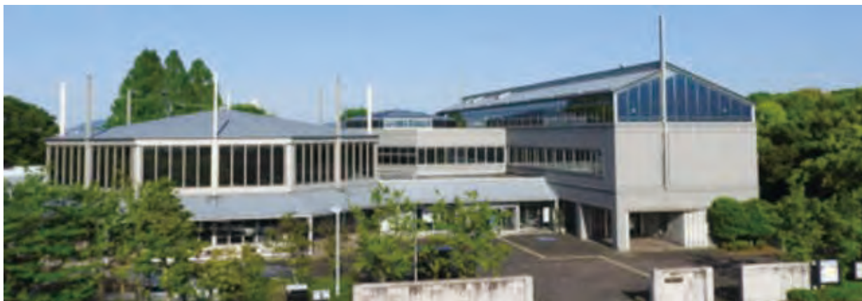
淡海環境プラザ外観
