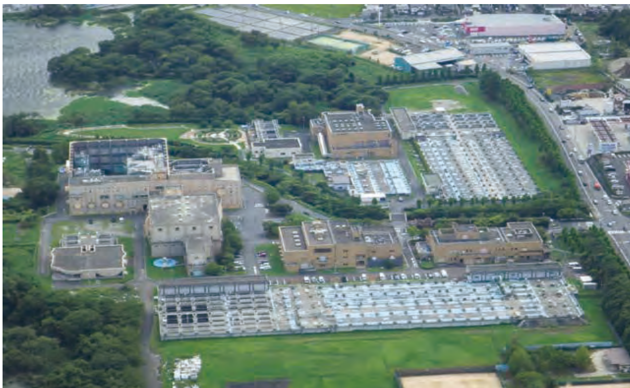
▲湖西浄化センター（大津市）
