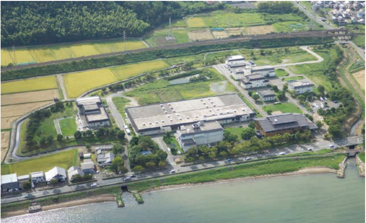
▲高島浄化センター（高島市）
