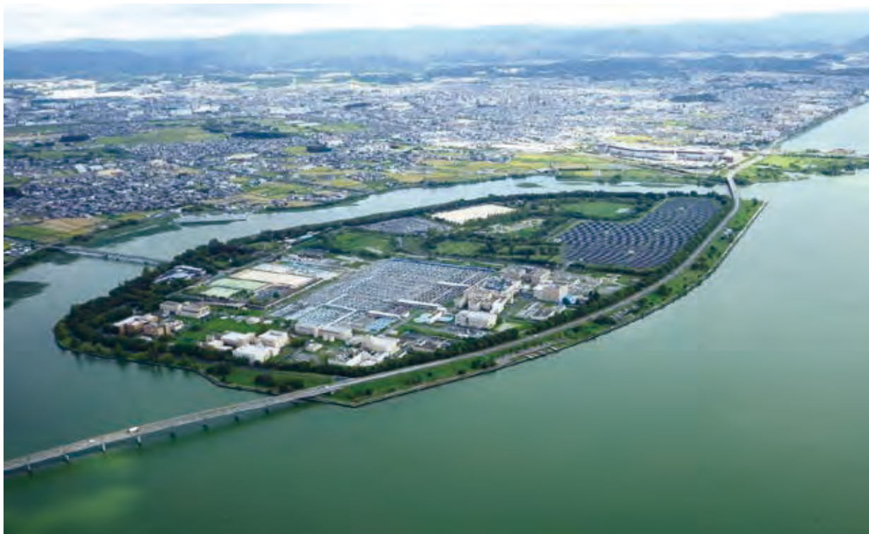
▲湖南中部浄化センター（草津市）
