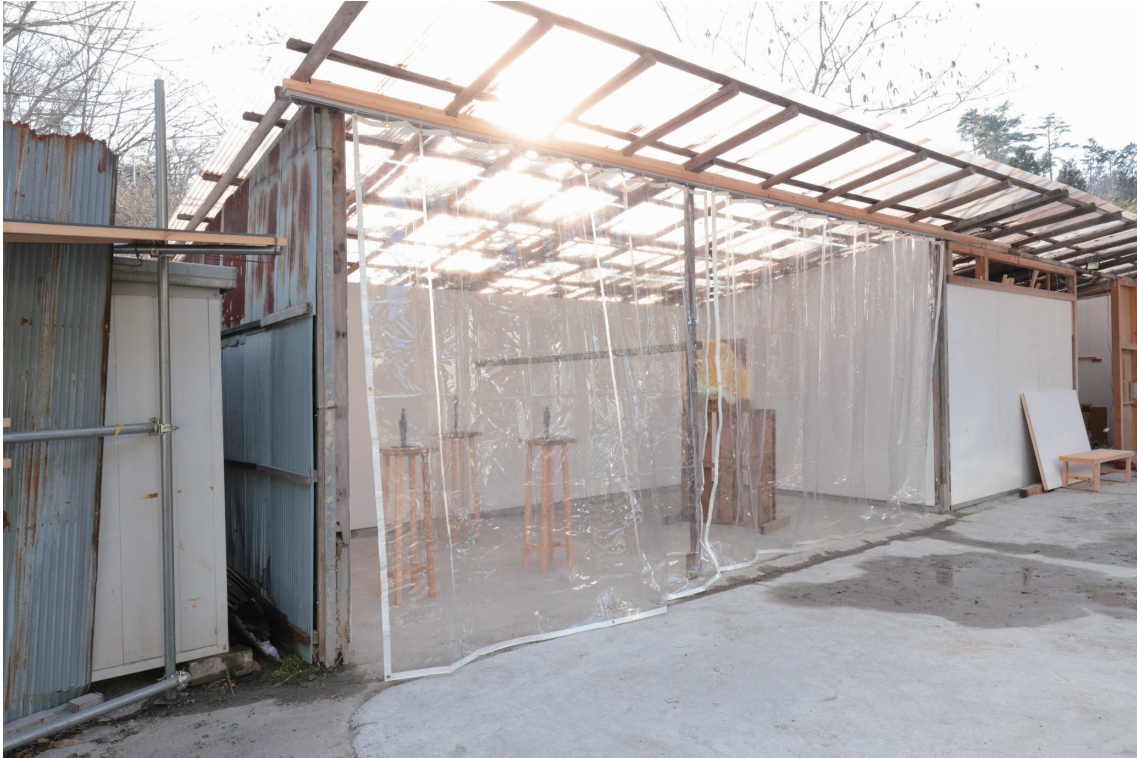
ギャラリーと他のスタジオメンバーの製作場所との間にビニールカーテンを設置
