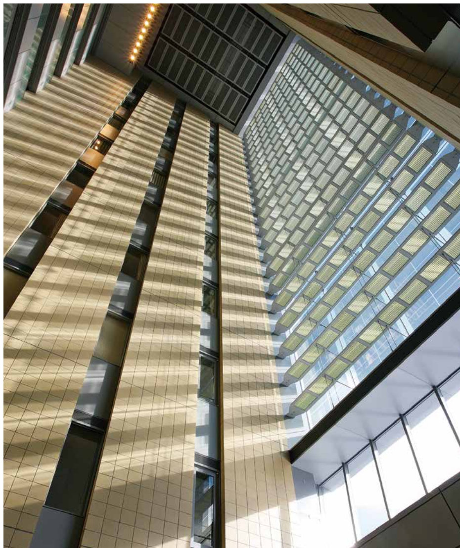
アトリウム（カーテンウォール部は太陽光発電パネル）
