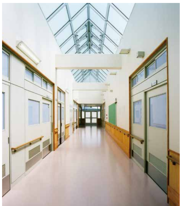
特別教室棟 廊下
