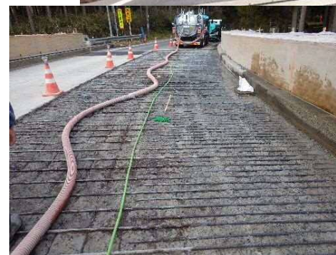
床版修繕状況
