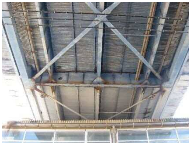
橋梁下面の状況
