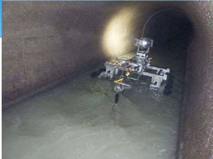
テレビカメラ自走車 管内調査状況
