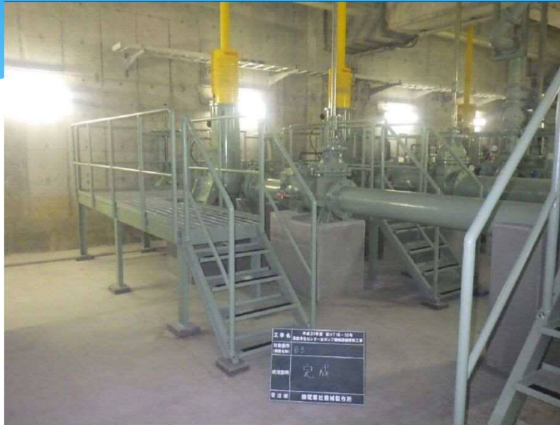
主ポンプ 更新
