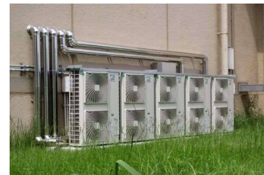
ポンプ棟 空調屋外機 更新 11
