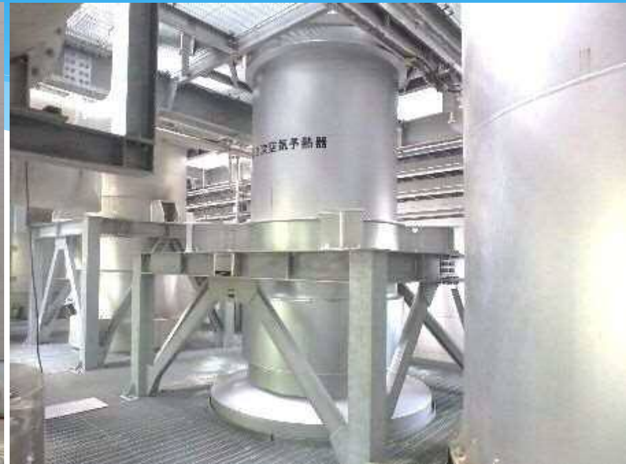
汚泥焼却設備2次空気予熱器 長寿命化
