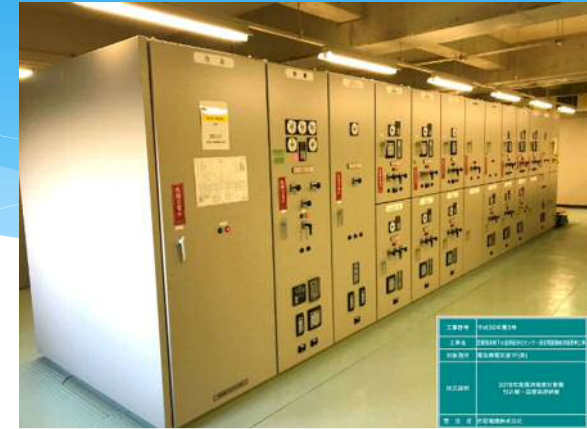
受変電設備 更新（現在施工中）
