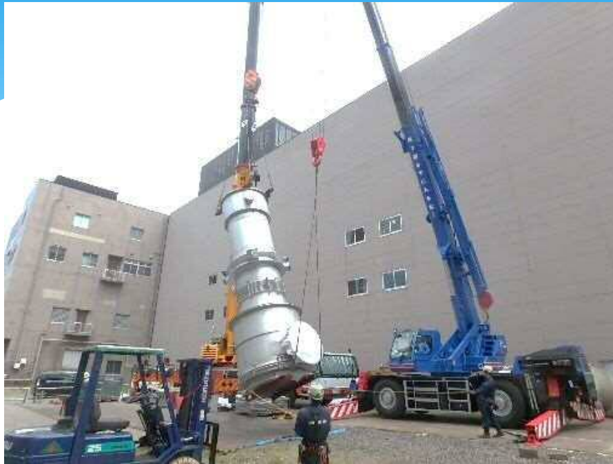
汚泥焼却設備2次空気予熱器 長寿命化
