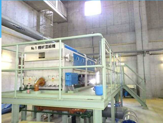
汚泥濃縮機 更新（現在施工中）
