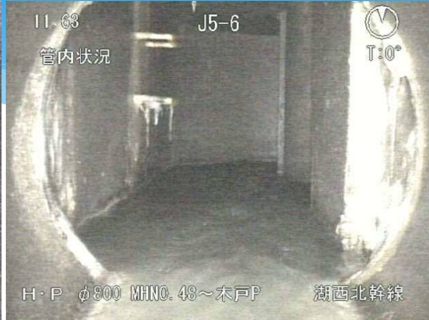
管渠内点検（テレビカメラ調査）の状況
