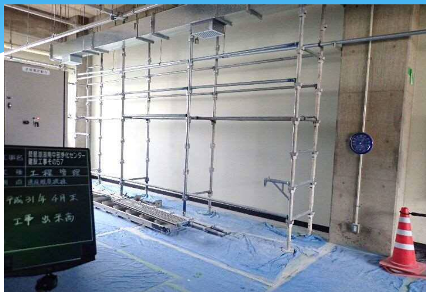
送風・脱臭機棟 耐震補強 (増壁)
