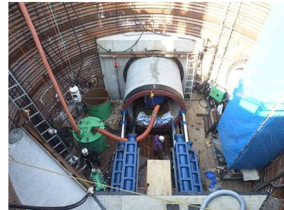
出庭 1 工区 施工状況
