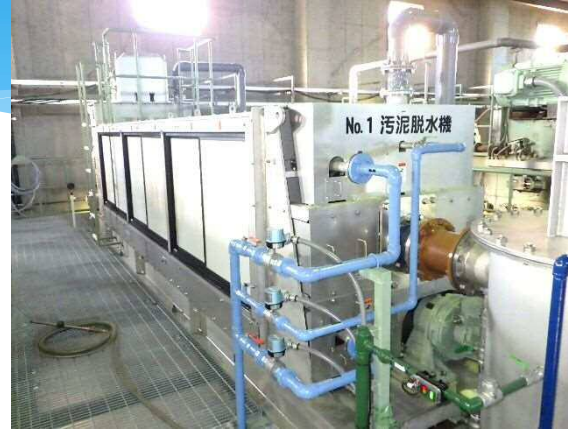
汚泥脱水機 更新（現在施工中）
