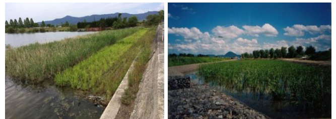
底質改善対策 (覆土工・植生工)
