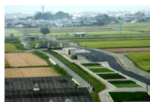
山寺川市街地排水浄化施設「伯母川ピオ・パーク」
