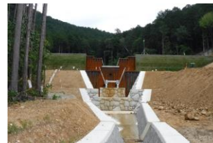
坂王井川支流砂防堰堤（野洲市）
