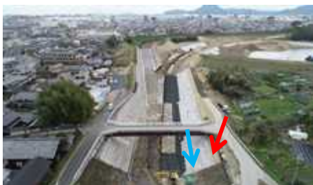
天井川の切下状況 金勝川(栗東市目川)
