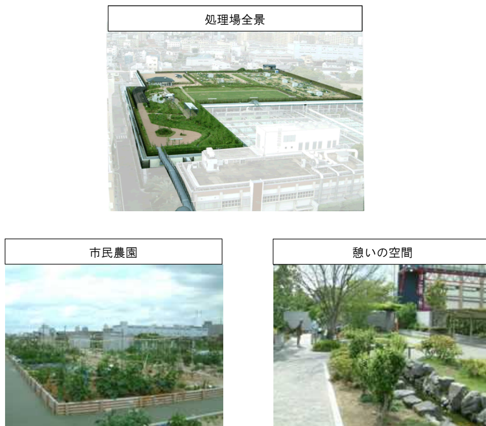
図 5-12 大阪市放出下水処理場写真
