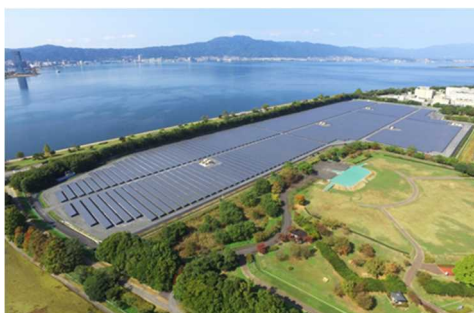
図 5-10 滋賀県矢橋帰帆島メガソーラー発電所全景
