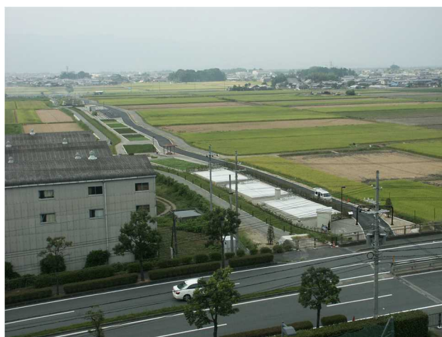
図 1-8 山寺川市街地排水浄化対策施設「伯母川ビオ・パーク」の全景
