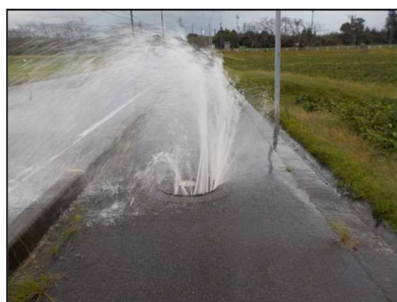
図 5-33 平成 29（2017）年台風 19 号 マンホール溢水状況
