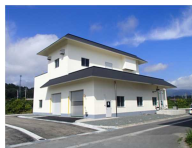
図 5-50 共同汚泥処理施設
