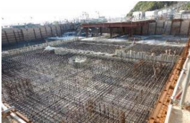
基礎工事の様子
