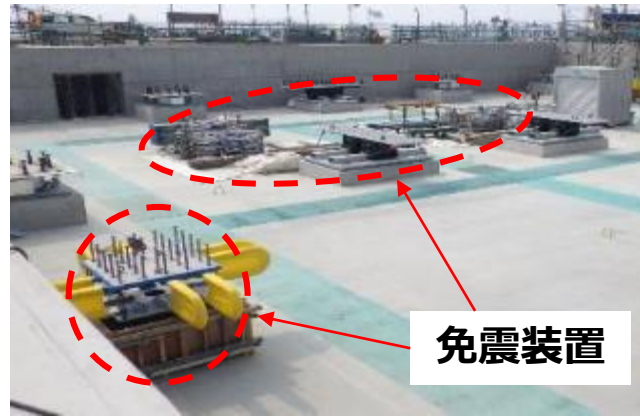
免震装置設置の様子
