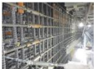
鉄筋追加設置状況
