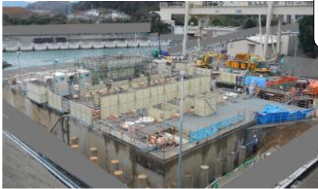
〔竜巻飛来物対策設備設置前〕
