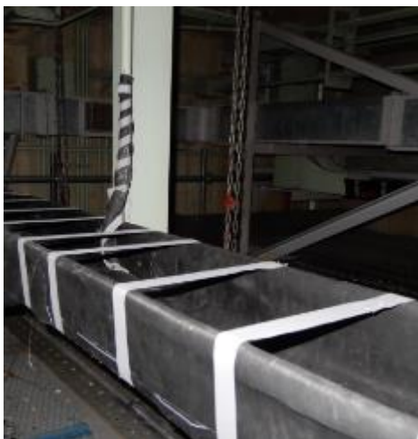
<防火シート施工箇所>
