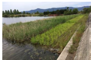
底質改善対策 (覆土工・植生工)
