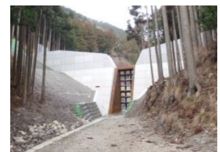
日野谷川堰堤（甲賀市）
