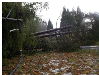
風倒木による被害(大津市)
