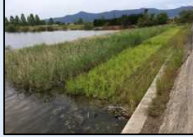
底質改善対策（覆土工・植生工）
