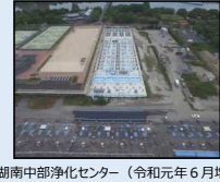
湖南中部浄化センター（令和元年6月増設）
