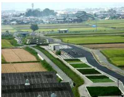
山寺川市街地排水浄化施設 「伯母川バイオ・パーク」
