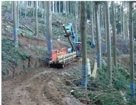
間伐施工地（長浜市）
