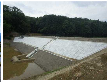
甲賀市甲賀町高野上ノ池地区ため池（平成29年7月改修）
