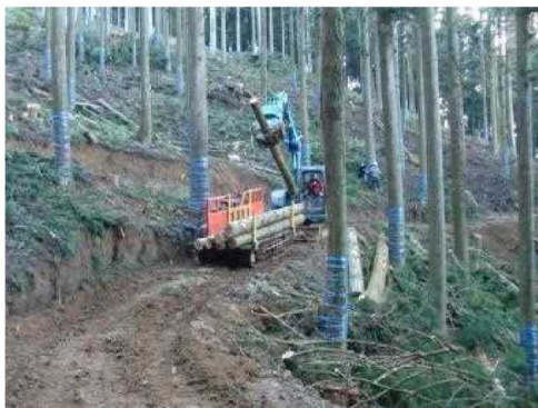
間伐施工地（長浜市）
