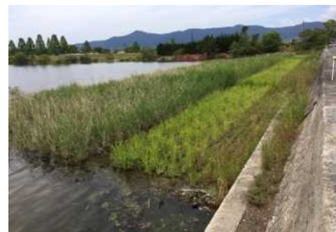
底質改善対策（覆土工・植生工）
