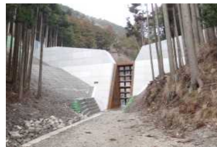
日野谷川堰堤（甲賀市）
