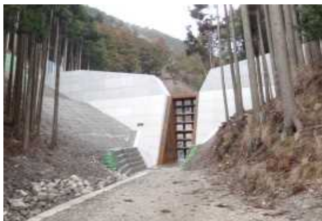
日野谷川堰堤（甲賀市）
