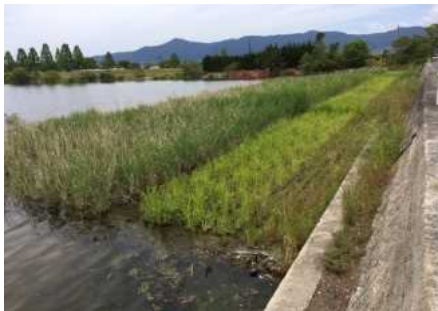
底質改善対策（覆土工・植生工）
