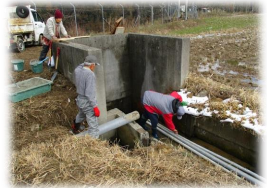
水路の補修(H27多賀町滝ヶ原)
