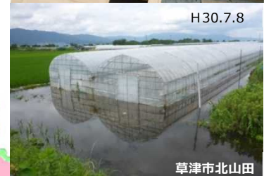
琵琶湖沿岸部の家屋や田畑で浸水被害が発生！
