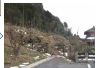
▲施工後防災機能の強化された里山
