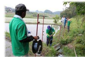
獣害防止柵の設置
