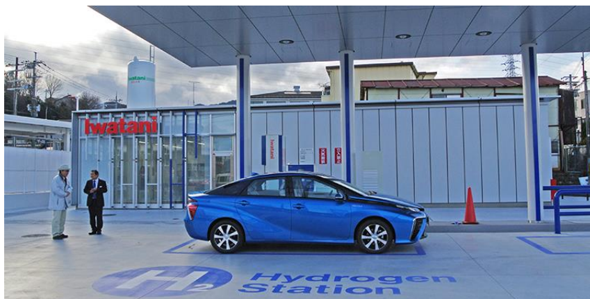
イワタニ水素ステーション 大津(大津市富士見台)
