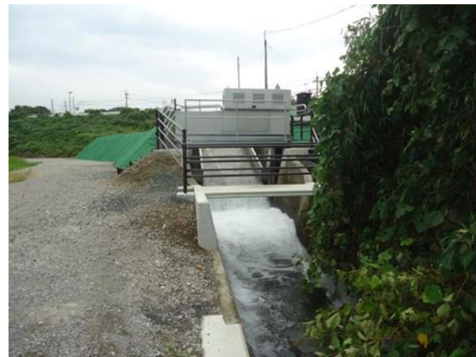
姉川エコ発電所1号機(米原市)
