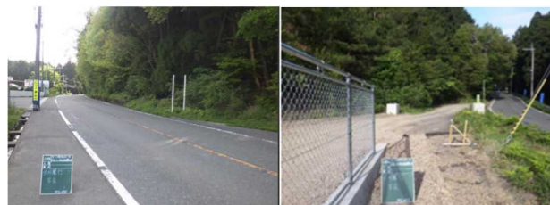
写真-1 着手前写真
