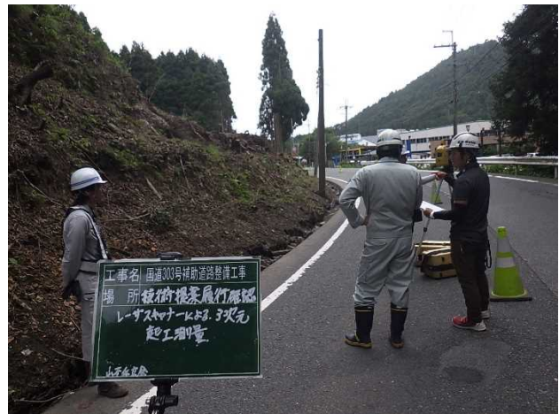
写真-3 測量実施状況
