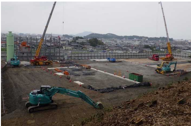
写真-2-2 仮設備施工状況
