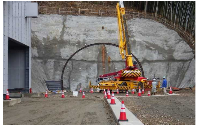
写真-2-3 坑口付け施工状況
