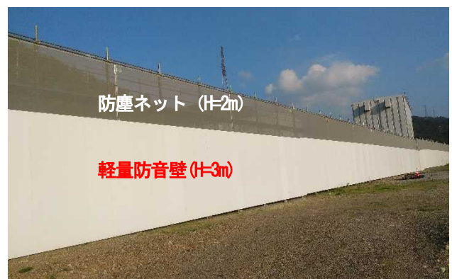
写真-5-2 軽量防音壁・防塵ネット
