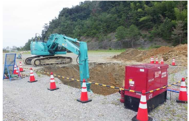
写真-5-1 超低騒音型機械を用いた骨材ピット掘削状況
