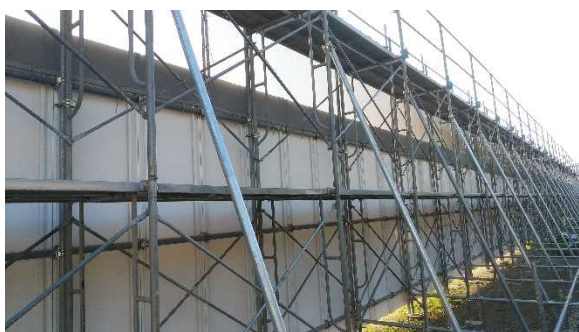
写真4-1 仮囲い点検用枠組足場
