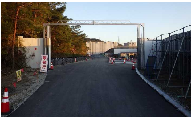
写真-2-1 工事用道路
