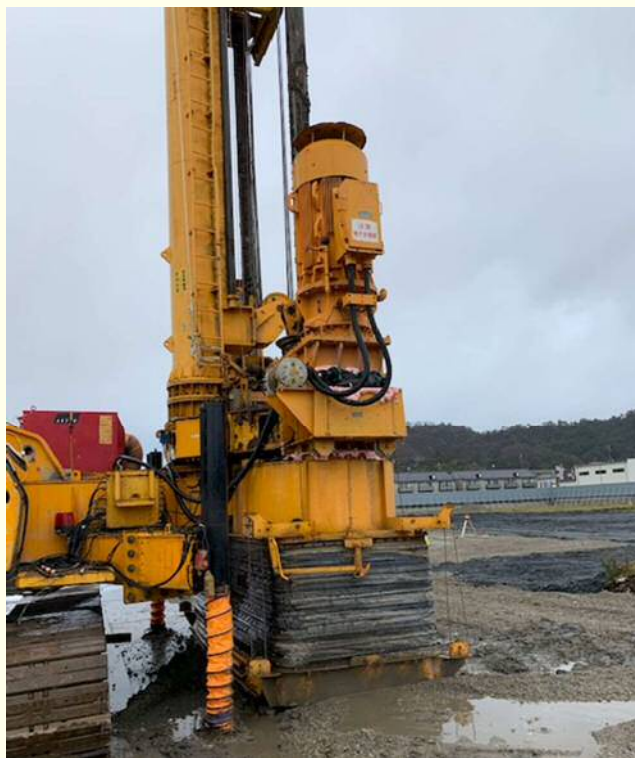
③地盤改良工事
