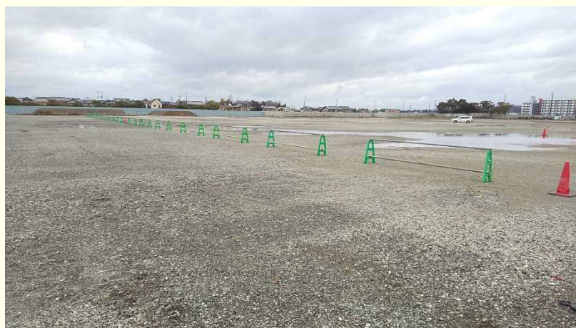
①既存施設撤去済み
