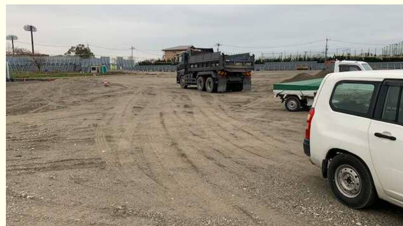
④造成工事
