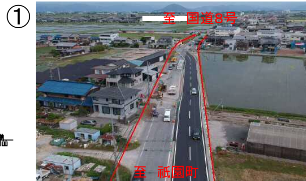
相撲地区の工事状況(R1.12月時点)
