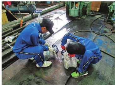
ていねいにバルブの点検 製作所
