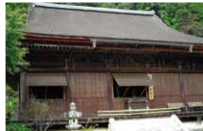
重要文化財桑実寺本堂
