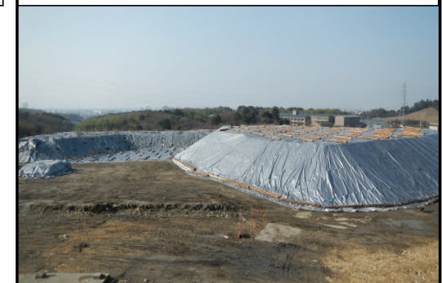
写真④ 掘削土仮置場(UVシート)
