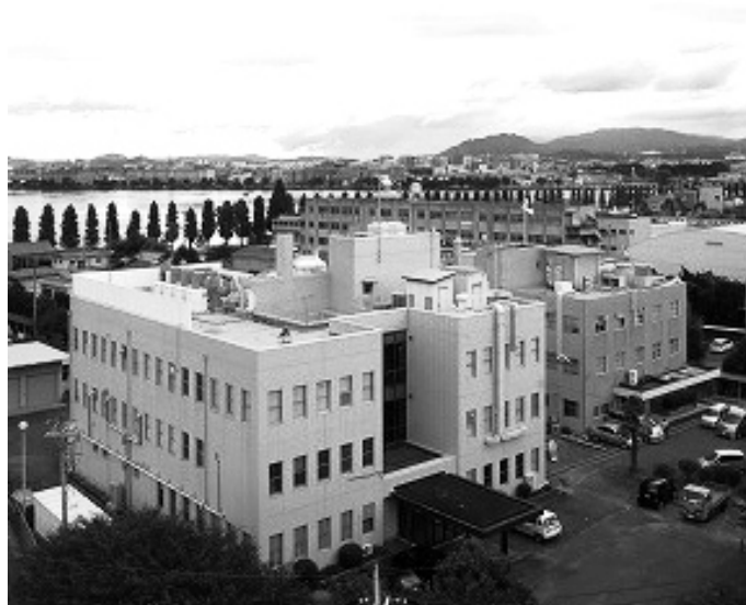
滋賀県衛生科学センター全景
