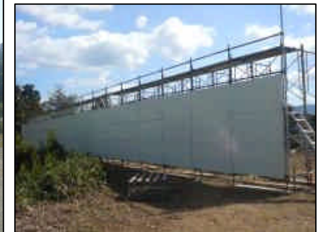
[防音パネル付仮囲い組立状況]
