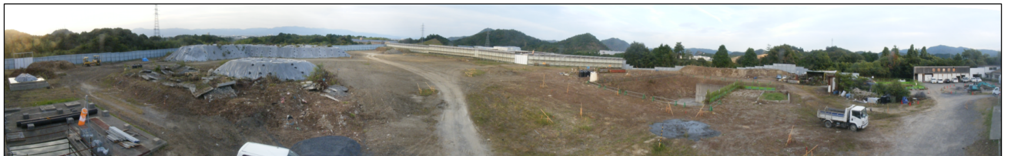
【工事施工状況写真】 [平成24年10月5日現在 全景]
