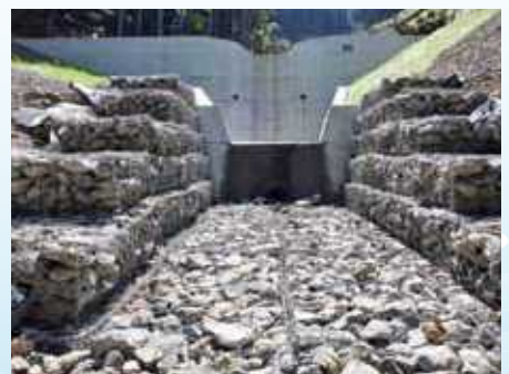
高島市朽木村井における復旧治山事業
