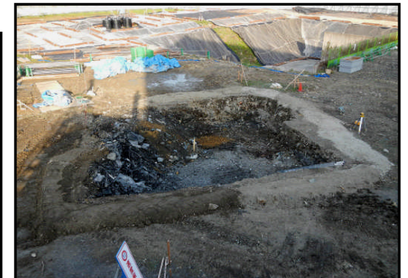
D区画 掘削状況
