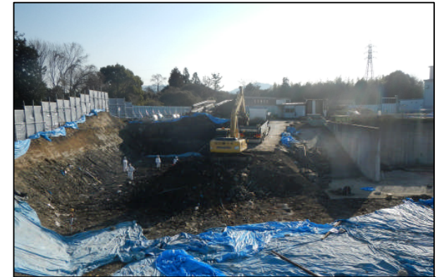
A区画掘削状況
