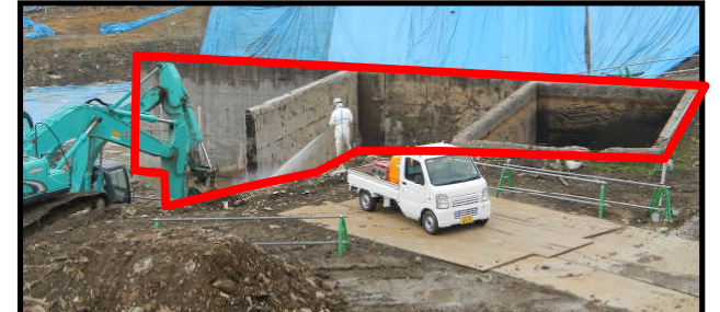
旧焼却炉跡撤去
