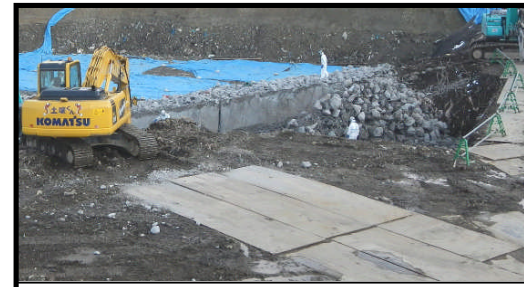
旧焼却炉跡撤去(2/9撮影)
