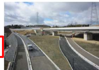
整備中の国道1号バイパス
