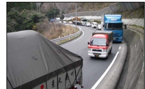
整備前の状況②
