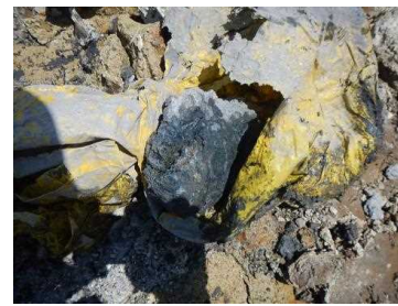
平成29年5月15日 廃石綿等(固結物)
