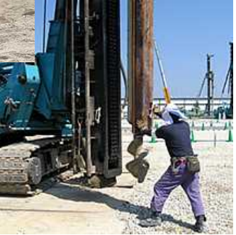
オーガ併用圧入工法 施工写真(例)
