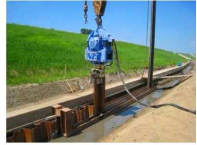
鋼矢板打設 施工写真(例)
