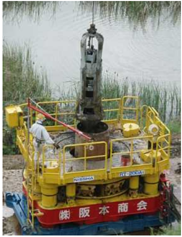
オールケーシング工法 施工写真
