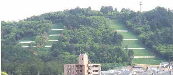
▲ 治山施設（山腹工）
